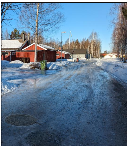
Figur 19: Hökbacksvägen, vy mot Kopparvägen i norr.
