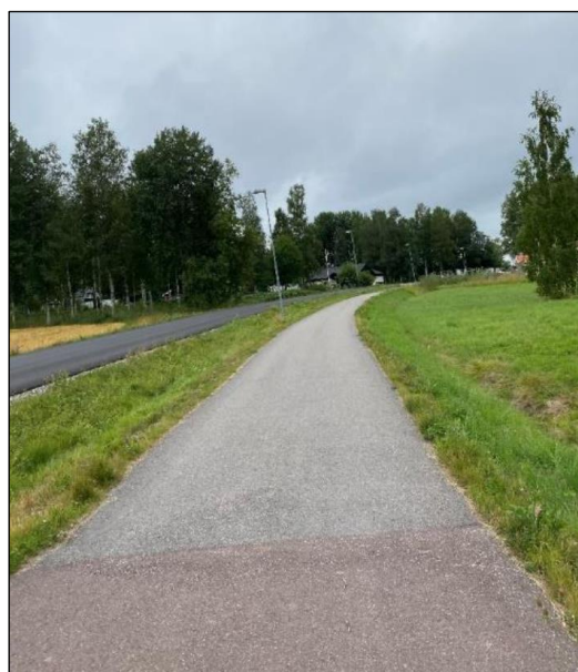
Figur 20: Separerad gång- och cykelväg längst Kopparvägen.
