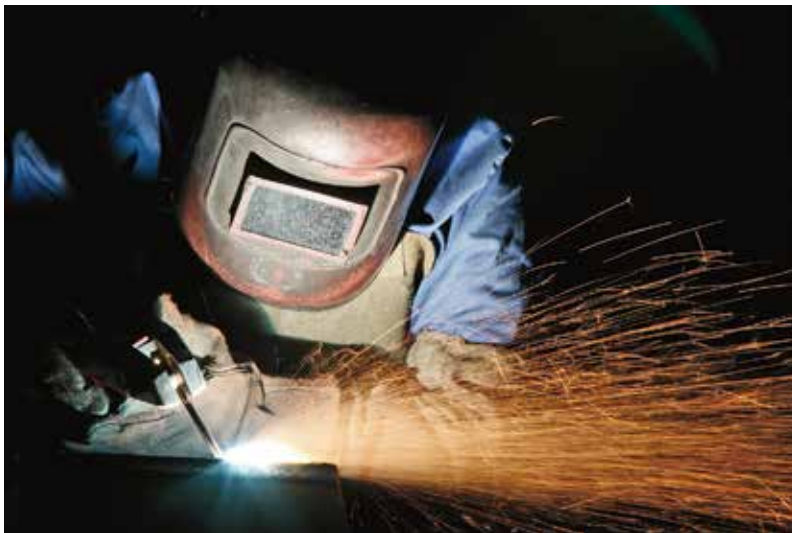
Svetsreparation av skada på cistern
