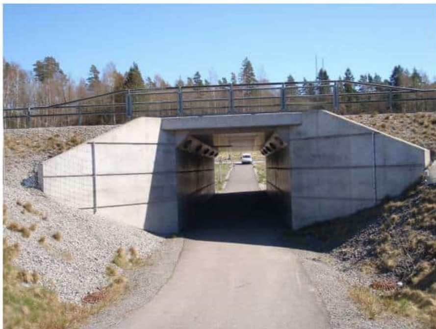
Figur 5.2:20 Exempelbild av förordat alternativ med plattrambro (bro 15-1548-1, bildkälla: BaTMan)
