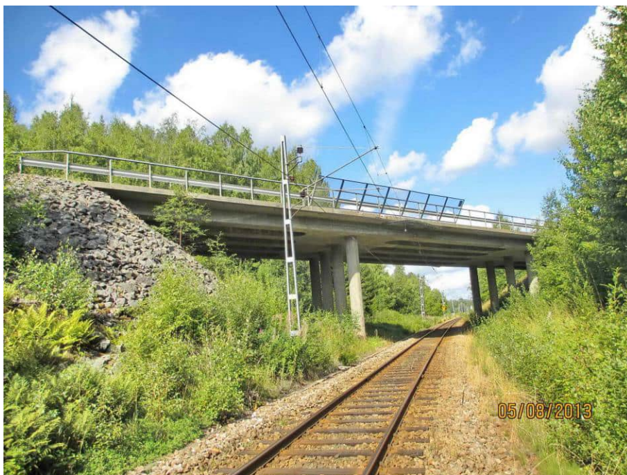
Figur 4.6:4 Bro över järnväg vid Västerbyhytta. Foto: BaTMan.
