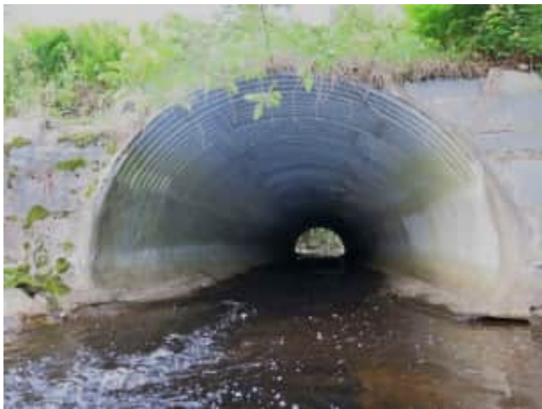
Figur 4.6:5 Bro över st. Lexens utlopp vid Tunkarlsbo. Foto: BaTMan.
