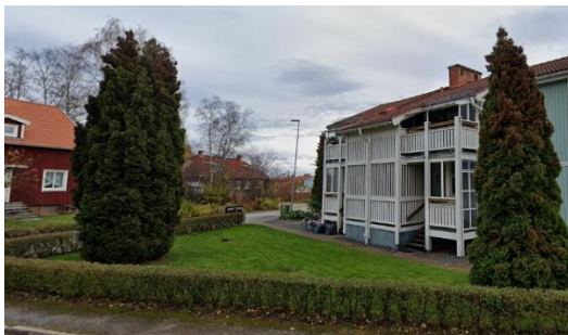
Berga gård skymtar mitt i bild. Flerfamiljshus ombyggt till loftgångshus inrymmer 4 lägenheter. Bilden är tagen från Bergslagsvägen norr om planområdet
